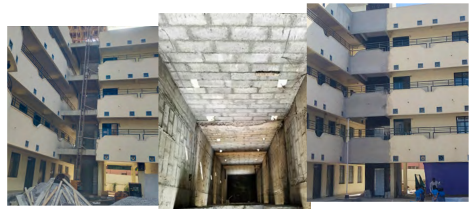
Entwicklung der Bauarbeiten für neuen Lift zwischen beiden Hauptgebäuden der SISA Academy
