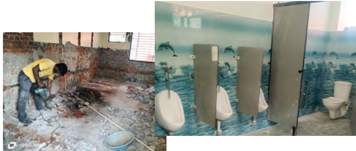
Renovation der Sanitäranlagen in der SISA Academy
